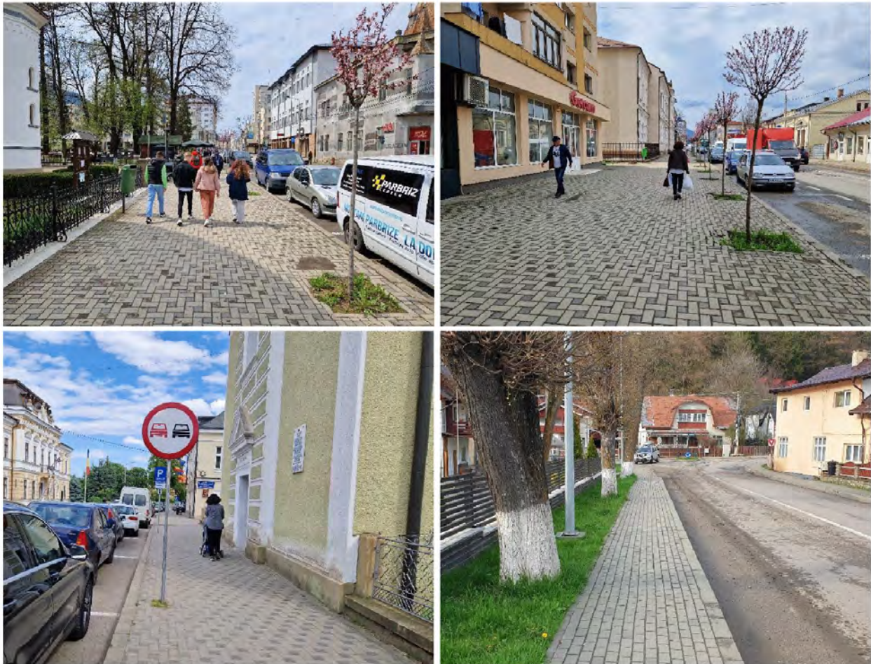
Figura 2.68. Trotuare în stare bună (exemplificare).
