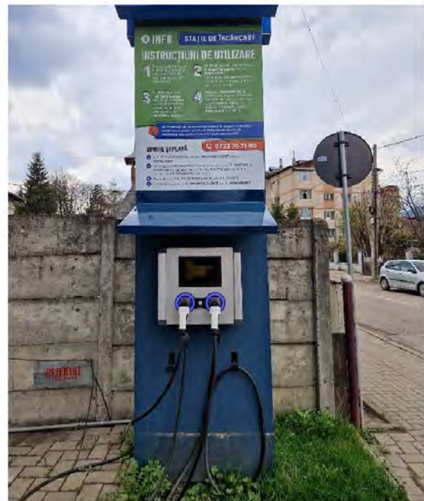
Figura 2.76. Stații de încărcare cu energie a vehicule electrice (exemplificare).
