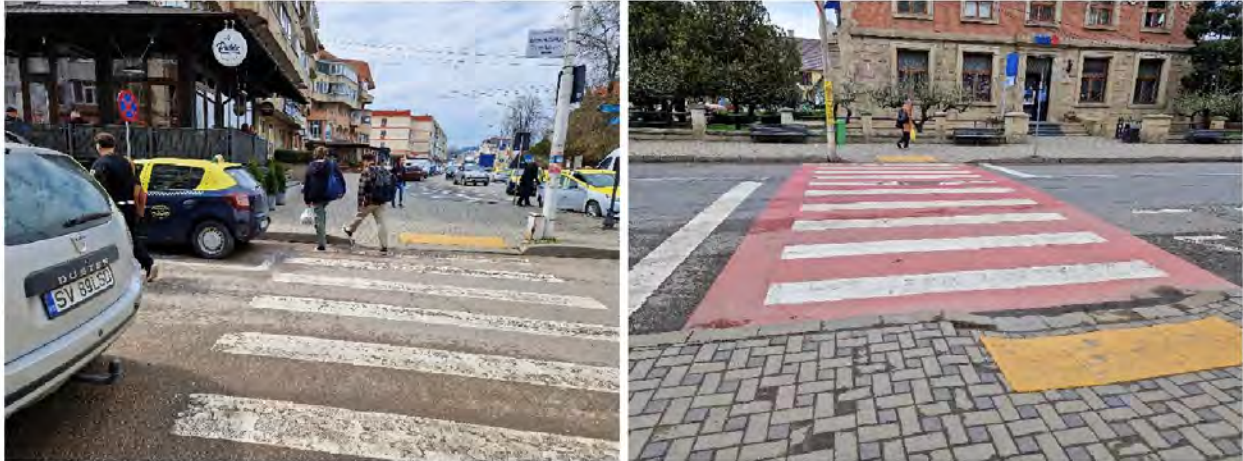
Figura 2.71. Treceri de pietoni accesibilizate (exemplificare).
